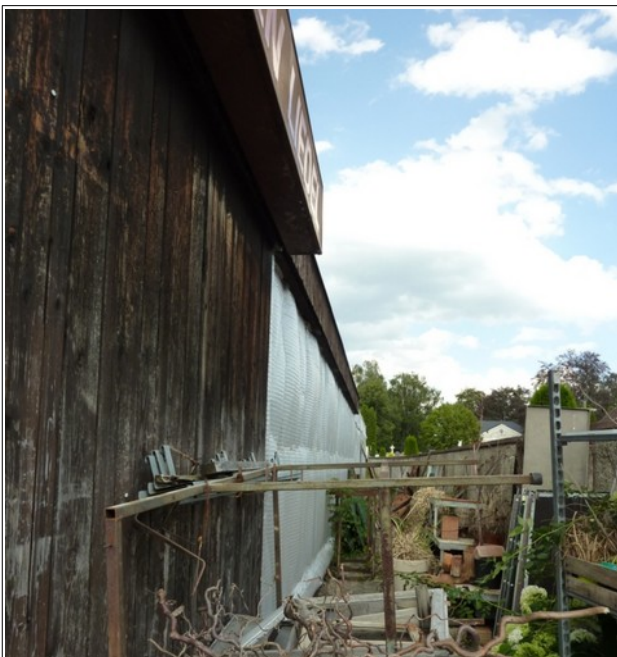
Südseite mit Einfassungen an den Dachkanten
