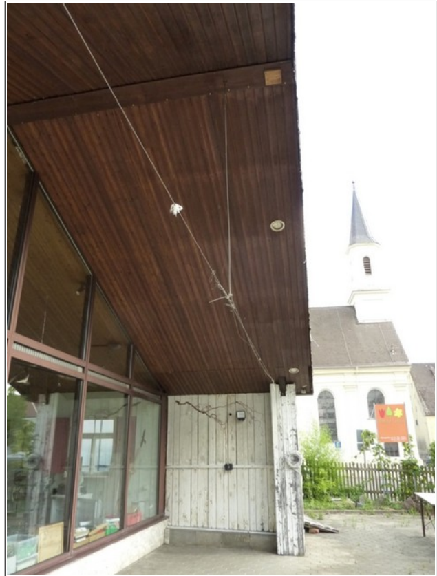
Deckelschalung an Vordach Westseite
