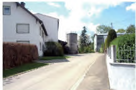
Einfamilienhäuser und landwirtschaftliche Gebäude
