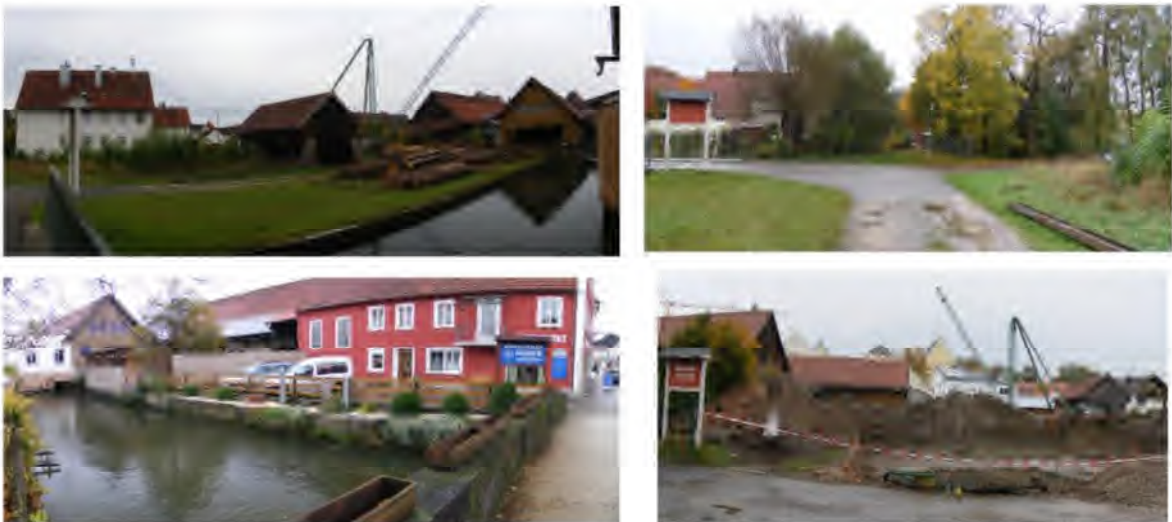
Abbildung 80: Fotos zur Kurzcharakterisierung Ortsmitte - Sägewerk
